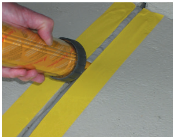
Påføring av fugemasse
