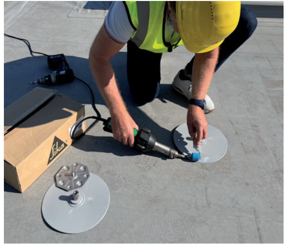
Mansjett blir montert på festebraketten og varmluftsveises på takbelegget.
