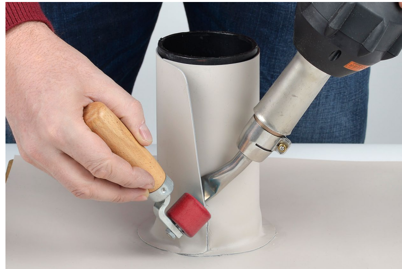
Sveis den vertikale overlappingen fra bunnen til toppen. Bruk et munnstykke på 20 mm.
