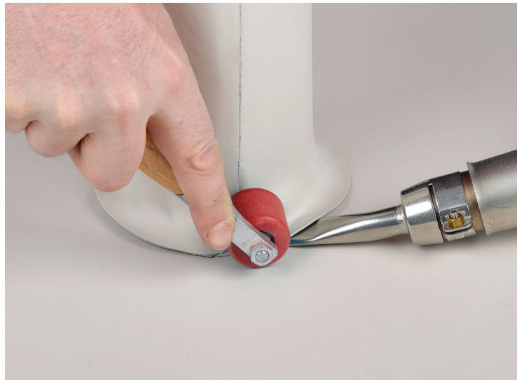
Sveis rørmansjetten til underlaget.
