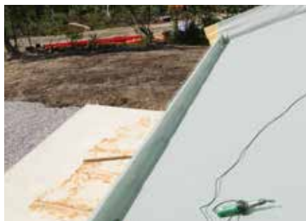
Eksempel på ferdig tekket takflate før legging av torv.
