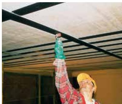
Forsterkning av armert betongdekke med SIKAR CARBODUR SYSTEMET: Sikadur 30 epoksyrim og Sika CarboDur-bånd.
