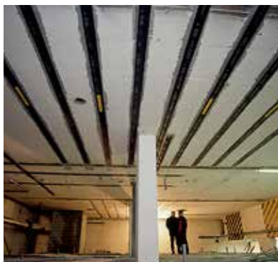
Forsterkning av armert betongdekke med SIKAR CARBODUR SYSTEMET: Sikadur 30 epoksyrim og Sika CarboDur-bånd.
