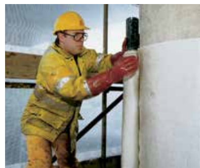
Påføring av SikaWrap for forsterkning av en brusøyle mot påkjørsler.
