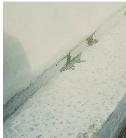
Enkel injeksjonsprosess på byggeplass
