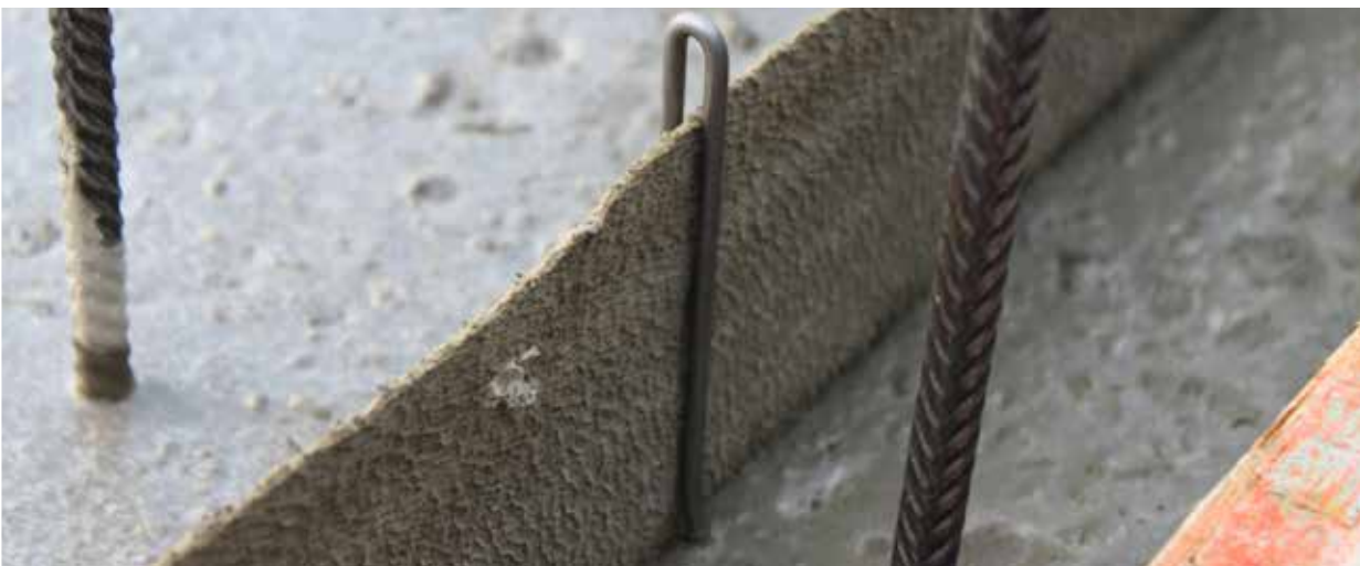
Mekanisk og kjemisk bundet, fleksibelt fugebånd for vanntetting av støpeskjøter
